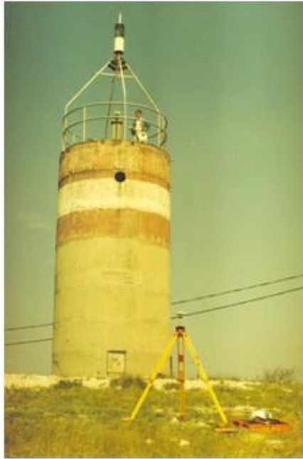
3-15. ábra Vasbeton mérőtorony
