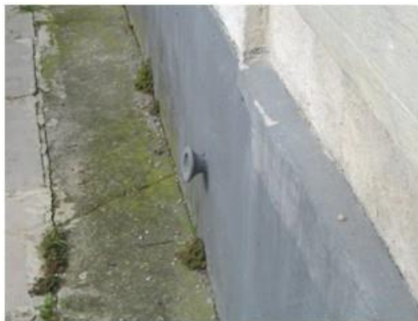
3-2. ábra Szintezési csap épület lábzatáiban
